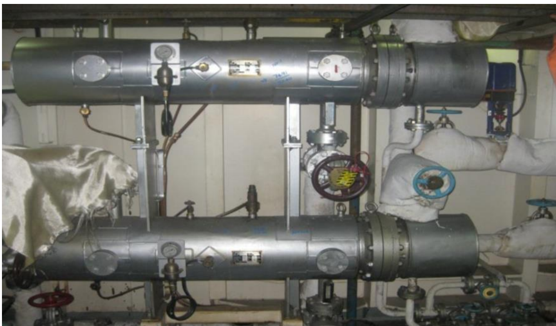
Kuva 14. Polttoaineen lämmitin (shipsbusiness, 2015)
