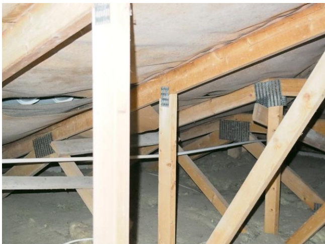
Kuva 27. Ulkoseinän pistorasian kaapeloinnin putkitus välikatolla.
