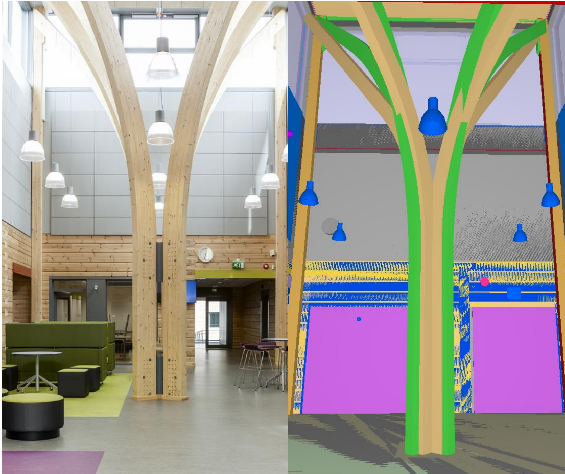
KUVA 10. Kohteen pilarit on mallinnettu kuten myös hirret (20; 21)
