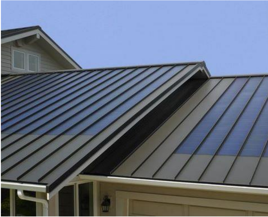
KUVA 10. Peltikattoon asennettua ohutkalvopaneelia (Rightway Roofing n.d.)
