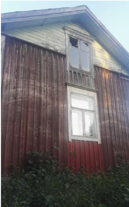
Kuva 3. Rakennuksen pääty ja ulkoverhoilu.
