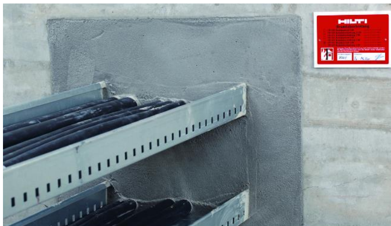
Kuva 3. Kaapelikourujen palokatko osastoivassa seinässä sementtipohjaisella palokatkomassalla (Hilti Oy 2018).
