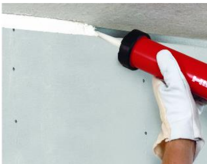
Kuva 4. Seinän ja katon välisen sauman tiivistys akryylipohjaisella palokatkomassalla (Hilti Oy, 2018).
