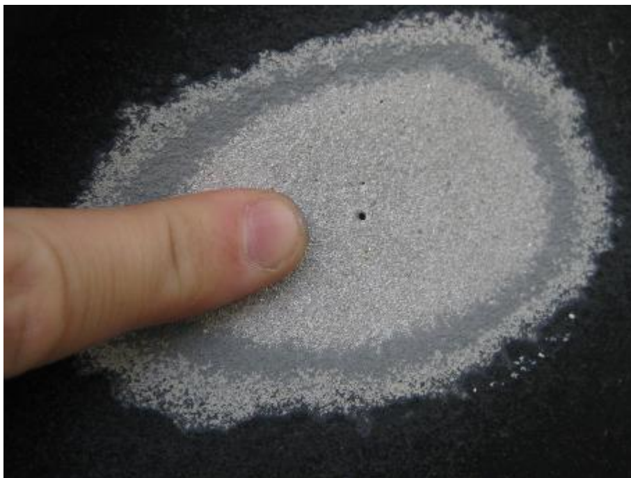
Kuva 7. Hiekkapuhalluksella puhdistettu pistesyöpymä vesirajan yläpuolella. Syvyys n. 5 mm. (Tanttu s.a.)
