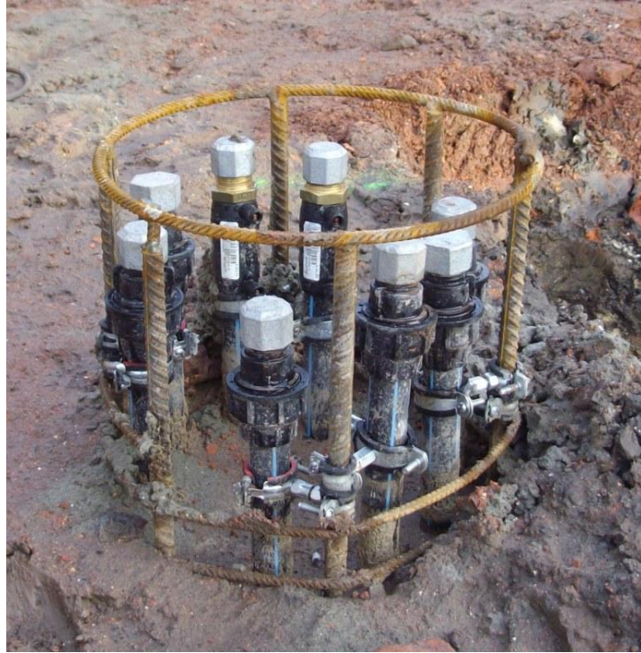
Kuva 5. Franki-paalutuksella toteutettu betoninen energiapaalu Ranskassa. (Franki Grondtechnieken BV, 2018)
