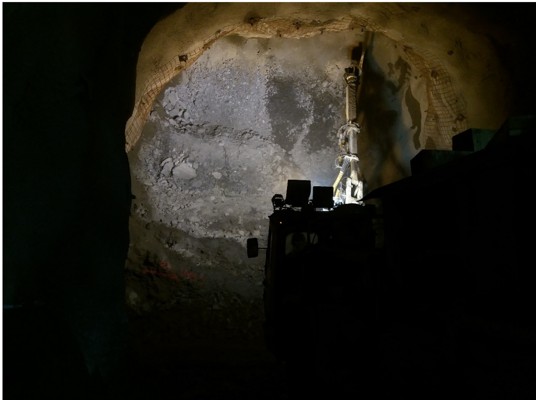
Kuva 11. Ruiskubetonointia CRF-perässä Kittilän kaivoksella
