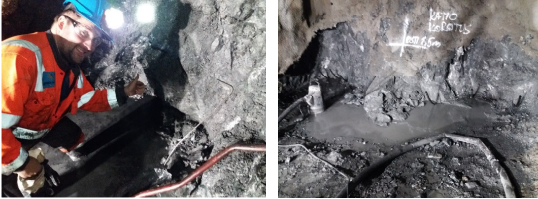
Kuva 7. Peränporauksen operaattori Juha Koivuniemi putkittamassa pohjareikiä alakätisessä vinotunnelissa RVT4.
