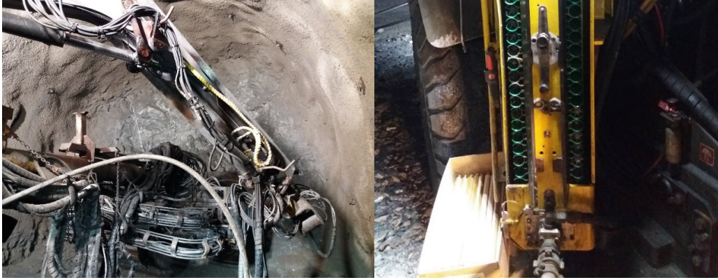
Kuva 11. Atlas Copco Boltec työkohteessa, pulppu- ja verkko-
