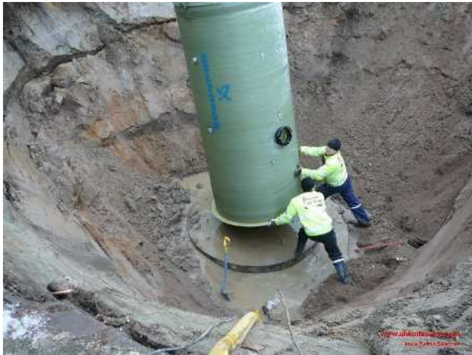
KUVA 4 Janakkalan kunnan Uhkoilan vesiosuuskunnan pumppaamon asennusta (Uhkoilan vesiosuuskunnan kuvia maanrakennusurakasta)
