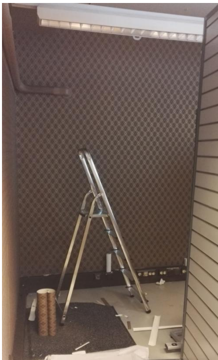
KUVA 12. Tila tapetoituna ja maalattuna
