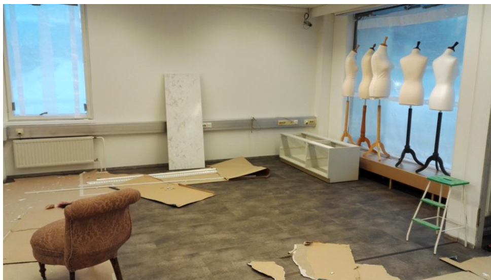
KUVA 56. Lattia asennettuna ja seinät maalattuna
