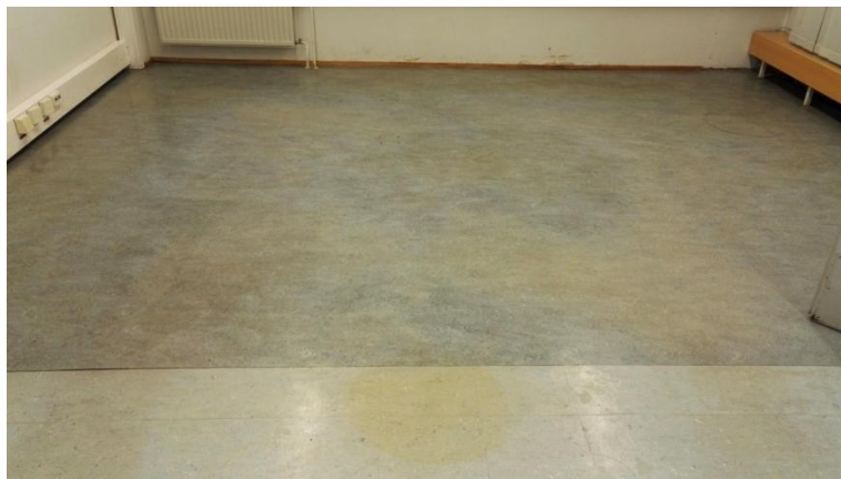
KUVA 51. Alkuperäinen lattipinta myymälässä
