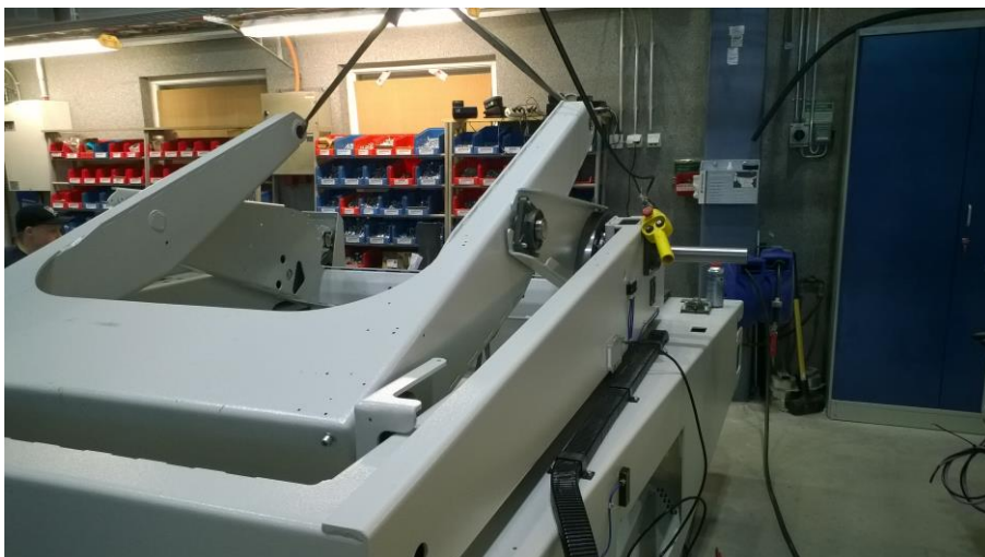
KUVA 9. Vipujen asennus hissiin.
