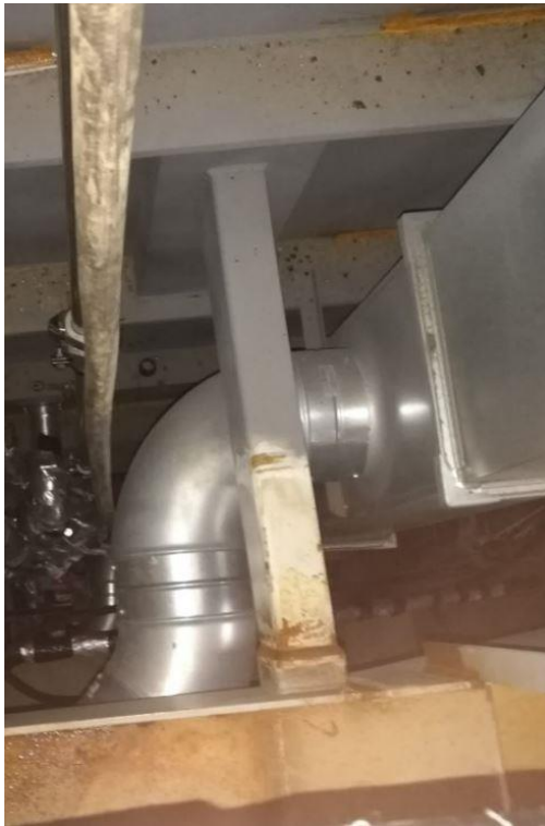
Kuva 9. Lepotason kiinnitys teräsputki-menetelmällä.
