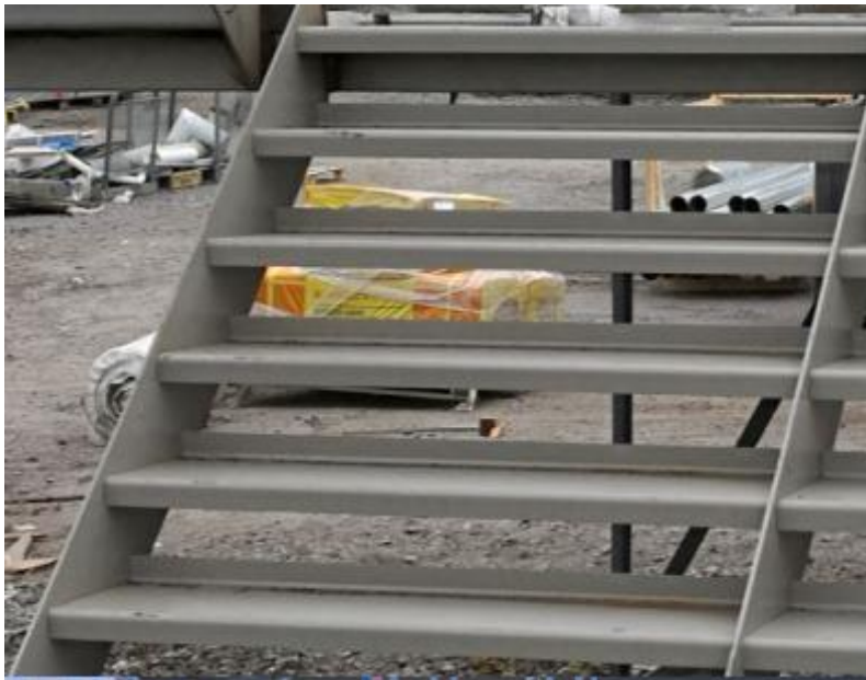
Kuva 3. Miehistöportaikon reisipalkit ja askelmat.
