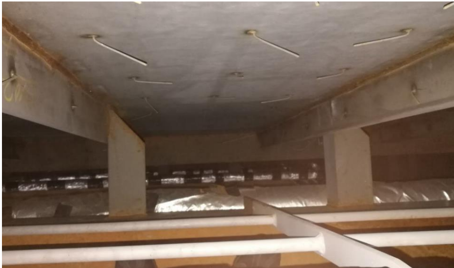
Kuva 8. Lepotason kiinnitys pituussuunnalta L-raudoilla.
