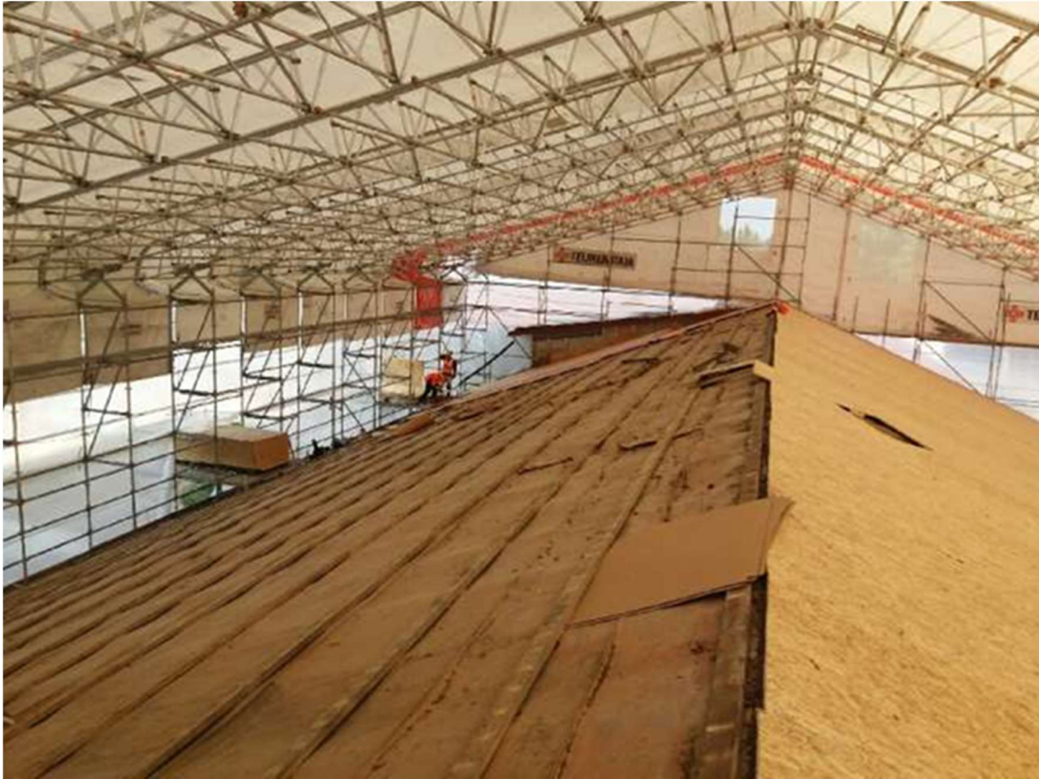
KUVA 10. Koko rakennuksen sääsuojaus. (18.)
