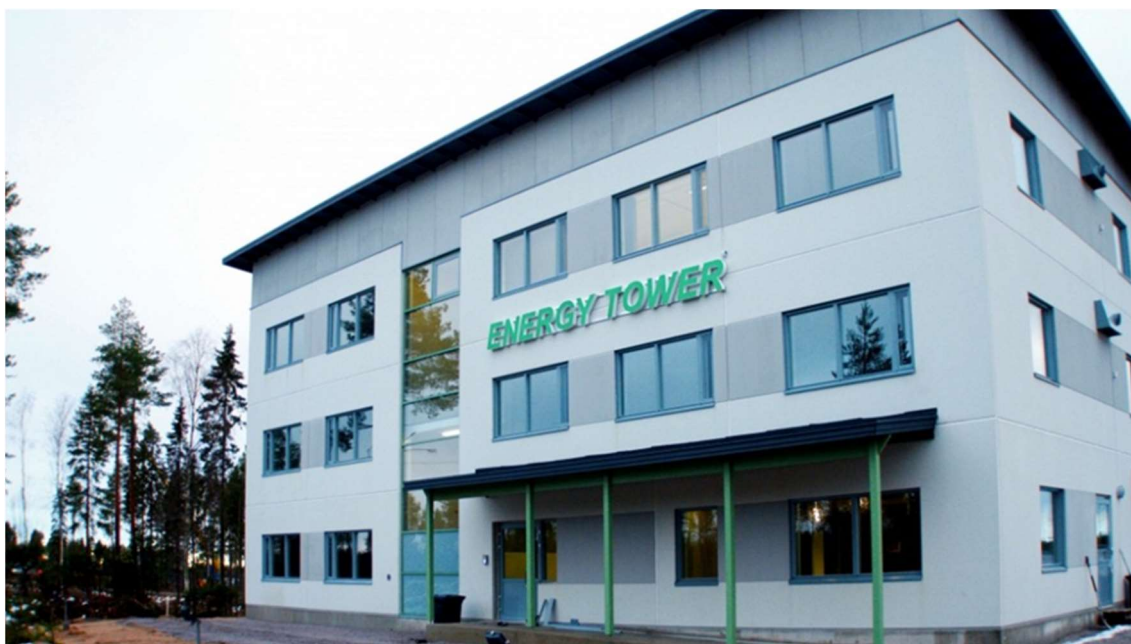
KUVA 5. Energy Tower -toimistorakennus, Pyhäjoki (12.)
