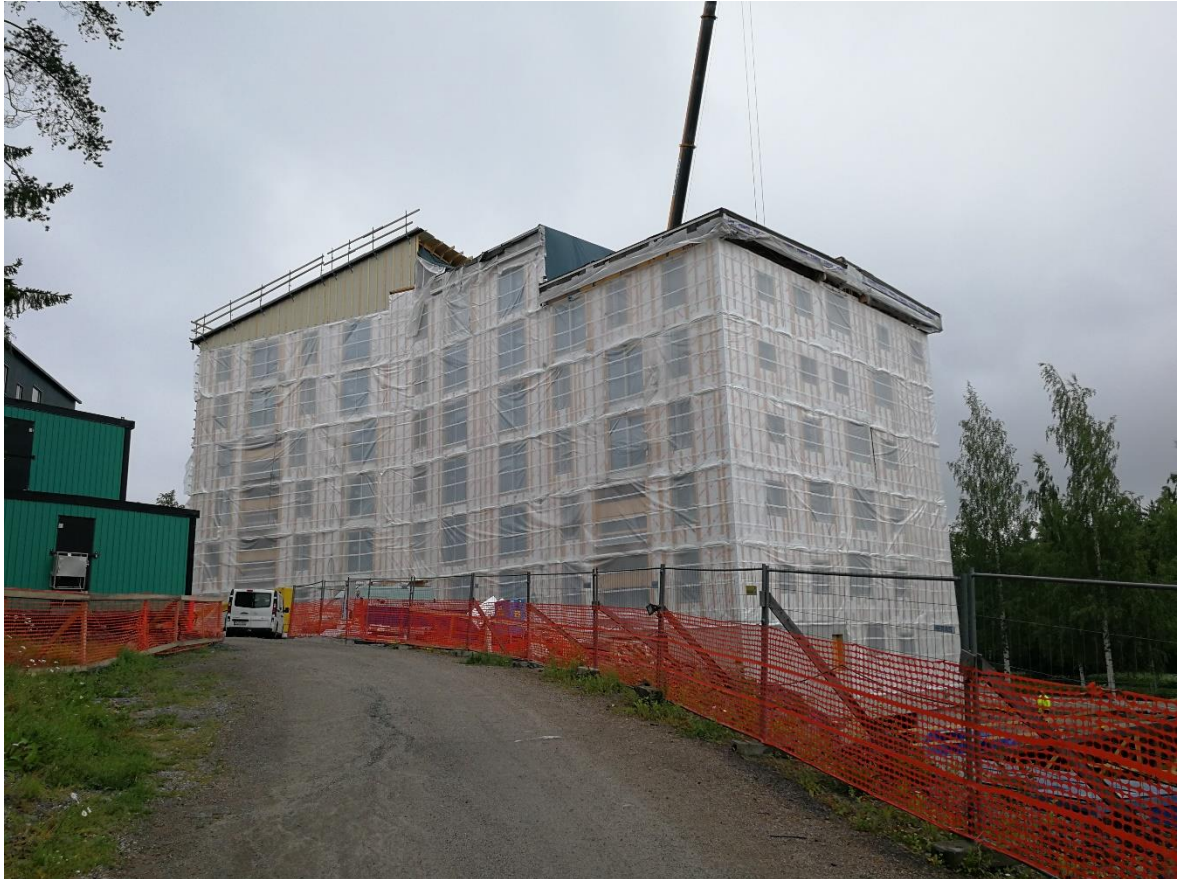
Kuva 16. Puolet katosta asennettu, ulkoverhousta ennen.
