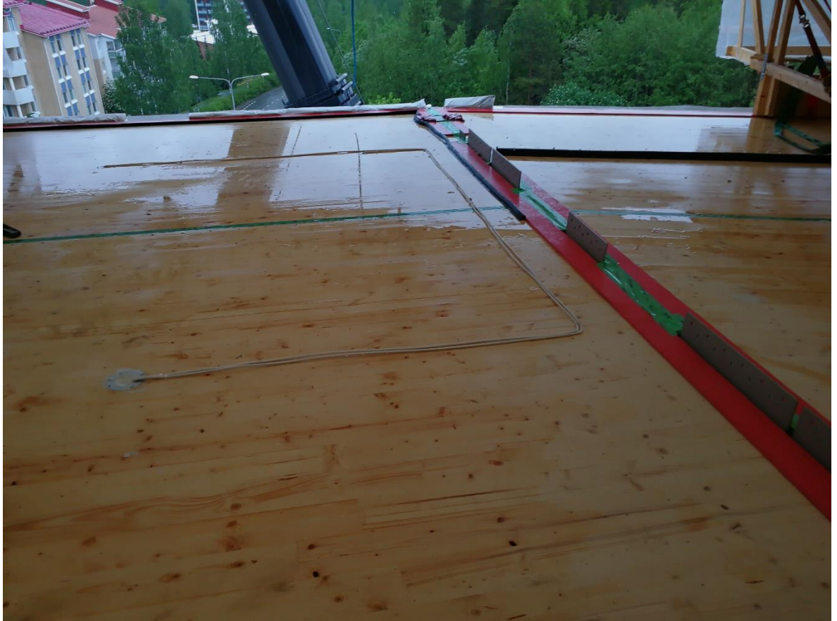
Kuva 15. Tuuli tuiversi vettä tilaelementtien päälle.
