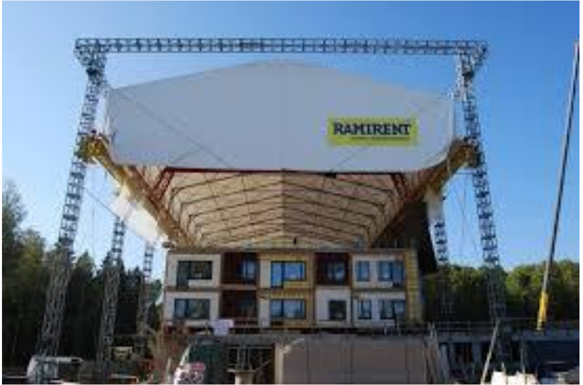
Kuva 3. Rakennussuojakatto nosturilla, Gibson Tower (Ramirent 2018).
