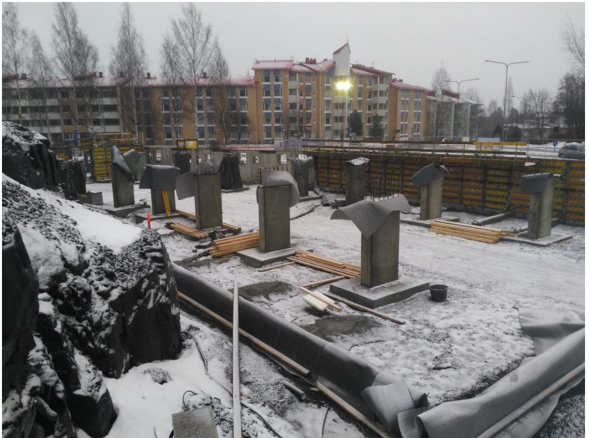
Kuva 8. Pilarit ja ulkoseinän muottia sekä anturaa suojattuna.
