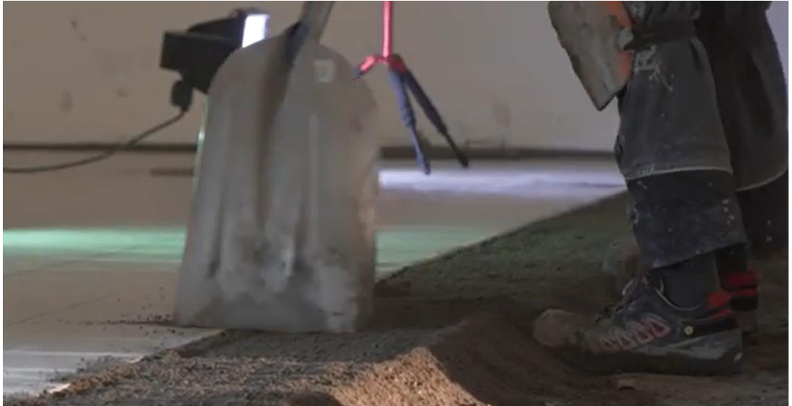
Kuva 6. Suomalaisella menetelmällä tehdyn lattian laatoitus
