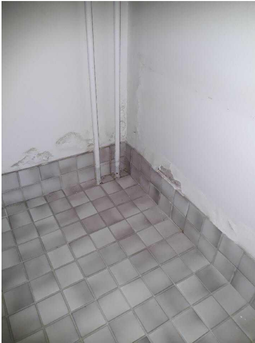
KUVA 8. Pukuhuoneen ja kellarikäytävän välinen seinä (Kuva: Jouni Kononow)
