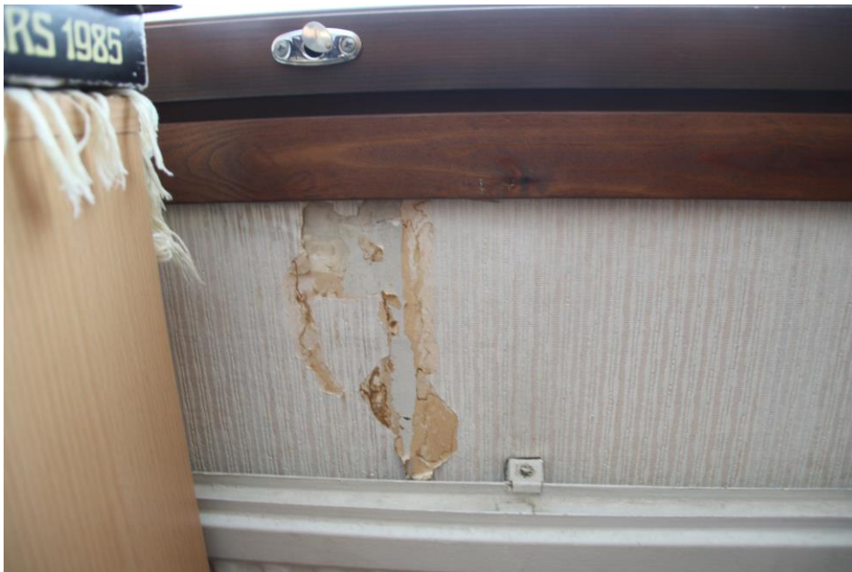
KUVA 6. Etupihan puoleinen ikkuna, mittaus 1
