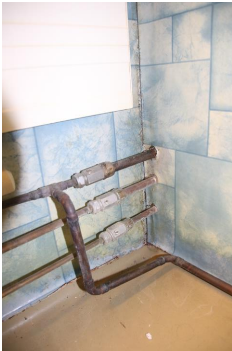
KUVA 14. Murtunut/huonosti saumattu muovimateriaalien saumat
