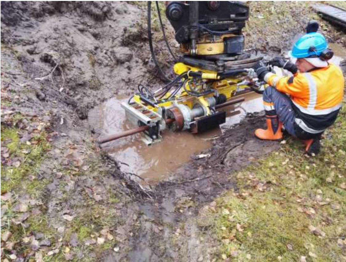
KUVA 6. Rummun aukaisuun käytettävä rumpupora
