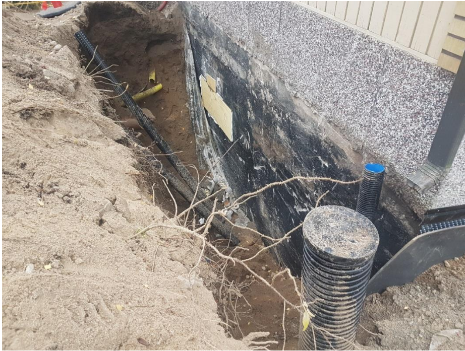
Kuva 3. Käytöstä poistettu kaukolämpöelementin läpivientireikä valettu umpeen. (Jyväskylän Energia n.d.)
