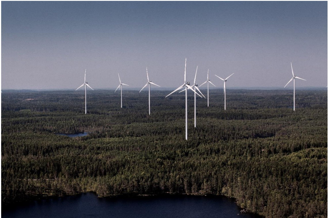
Kuva 1. Lemnhultin tuulipuisto. (Courtesy of Vestas Wind Systems A/S 2018.)
