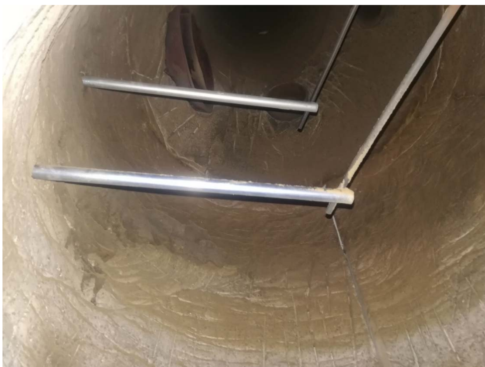
KUVA 1. Kattilan sisäosan muuraukset
