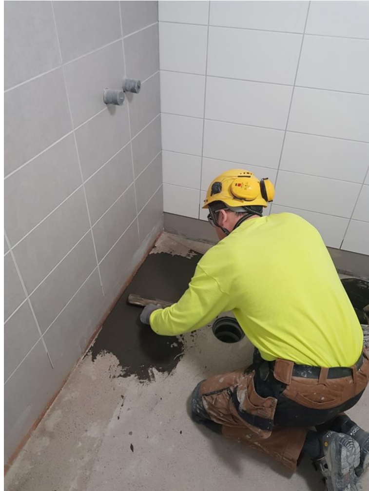
Kuva 13. Kylpyhuoneen kaatojen ja alustan tasaisuuden korjaus. (YIT Rakennus Oy 2018).
