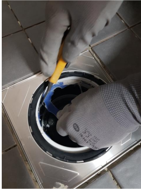
Kuva 7. Kaivon siistiminen ylimääräisestä vedeneristeestä. (YIT Rakennus Oy 2018).
