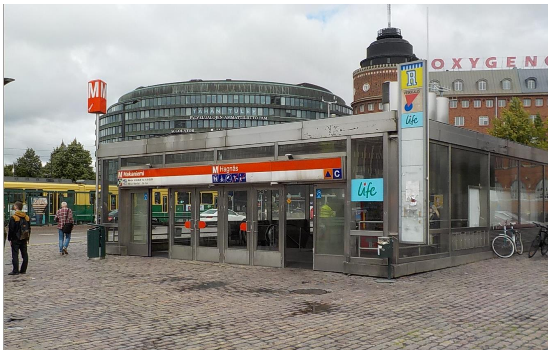
Kuva 1 Hakaniemen metroaseman lippuhallin sisäänkäynti. (Miettinen 2017)
