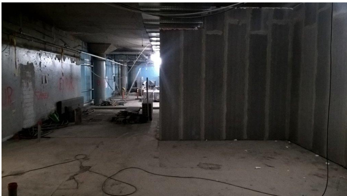
Kuva 5 Asennettu ako-elementti. (Miettinen 2017)
