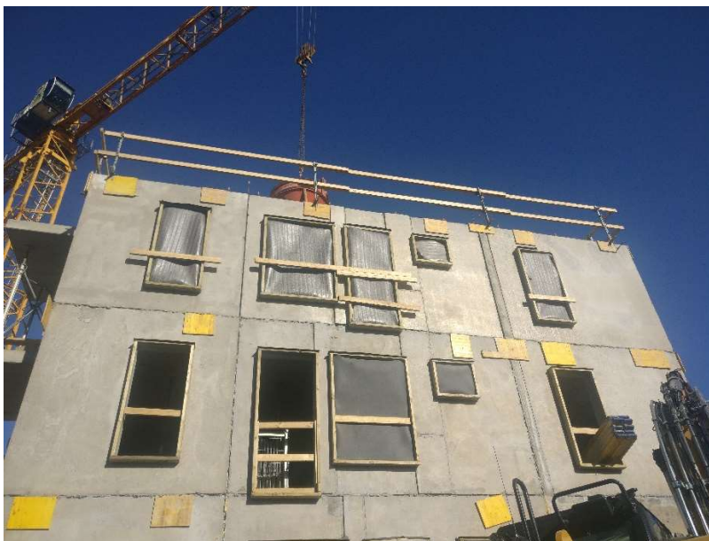
Kuva 6. Ikkunat ja aukot suojattu ja tukittu lämmitetyssä kerroksessa holvivalun alapuolella.
