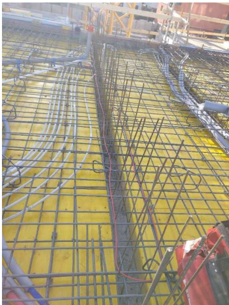
Kuva 8. Paikalla valettavan seinänä kohdalle asennettu lämmityslanka.
