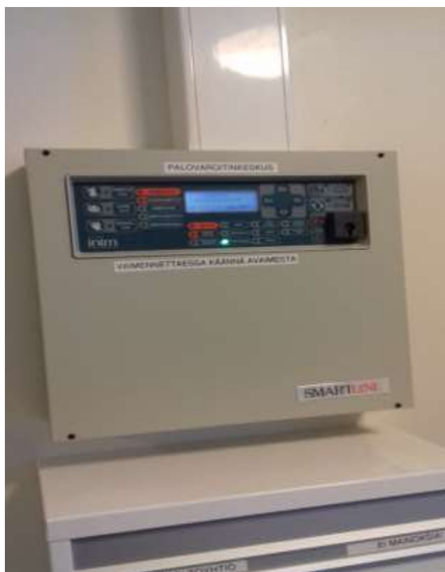
Kuva 3. Esimerkkikohteen palvaroitinjärjestelmän keskusyksikkö.
