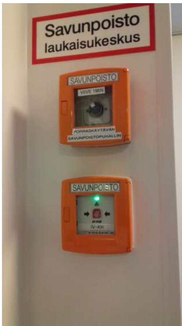
Kuva 2. Esimerkkikohteen savunpoiston laukaisukeskus.
