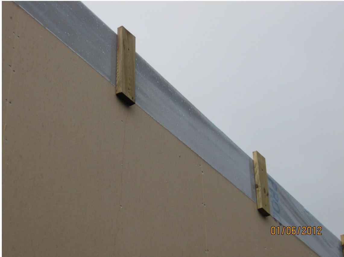
KUVA 7. Elementin yläpää suojattu muovilla. (Skanska Talonrakennus Oy)
