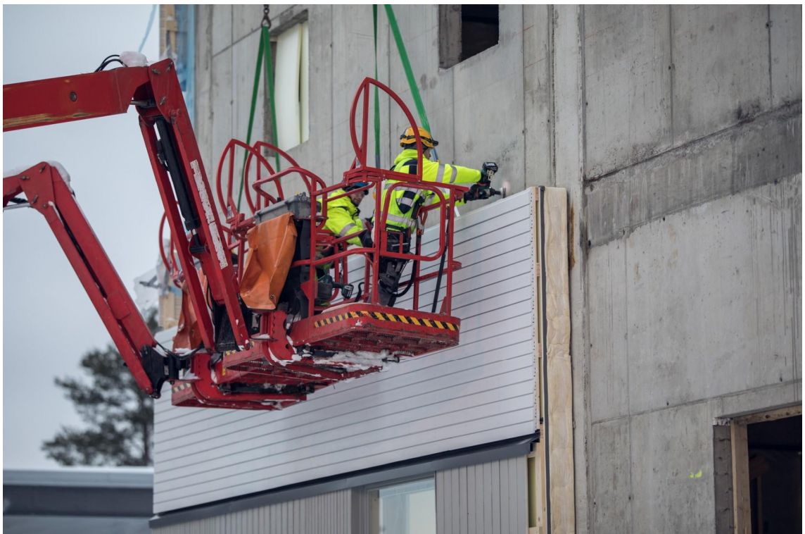
KUVA 14. Puujulkisivuelementin asennusta Kainuun uudella sairaalalla. (Kainua.fi)
