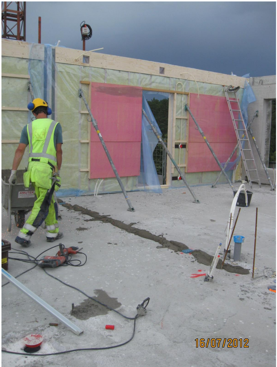
KUVA 9. Puujulkisivuelementin asennusaikainen tuenta. (Skanska Talonrakennus Oy)
