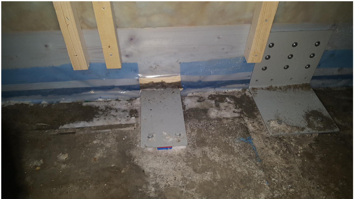
KUVA 12. Elementin kiinnitys välipohjaan teräsosin. Kainuun uusi sairaala. (Sweco Rakennetekniikka Oy)
