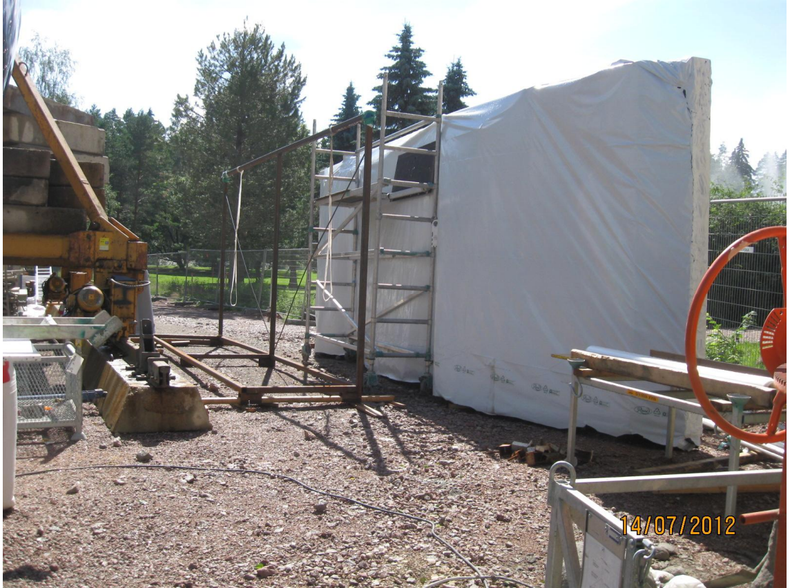
KUVA 6. Valmiita elementtejä varastoituna työmaalla. (Skanska Talonrakennus Oy)
