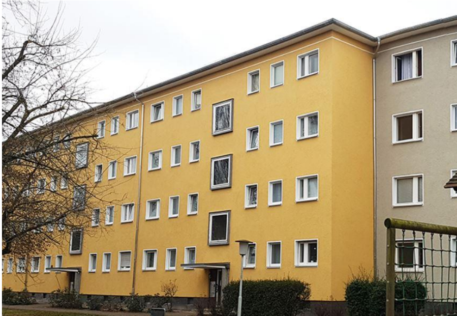
Figur 9, Bild på fastigheten som sanerades i Berlin 2017 med Aerobran.
