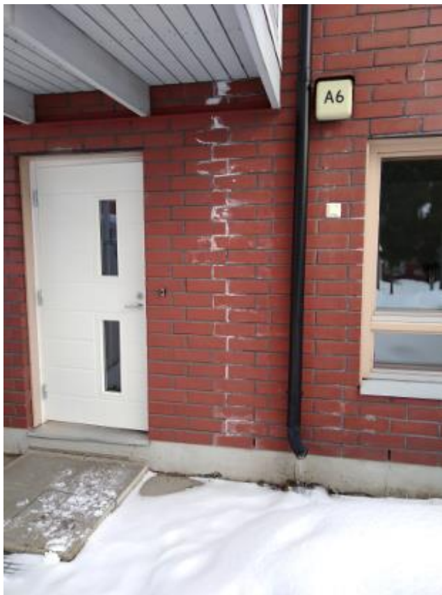
Kuvio 12. Tiilihärmää julkisivussa
