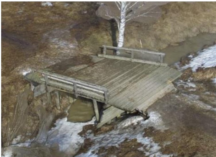
KUVA 18. Pix4d ohjelmalla mallinnettu puusilta
