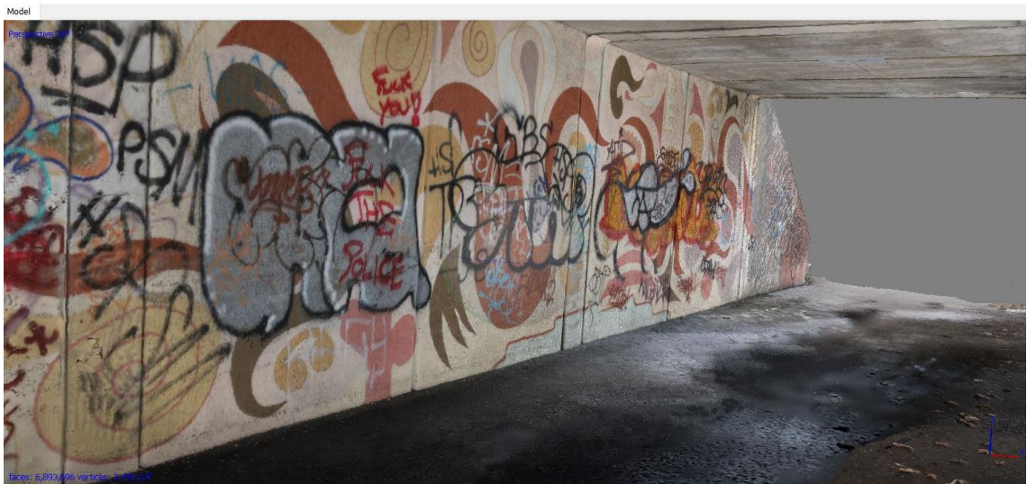
KUVA 28. Järjestelmäkameran kuvista mallinnettu alikulkutunneli sisältä
