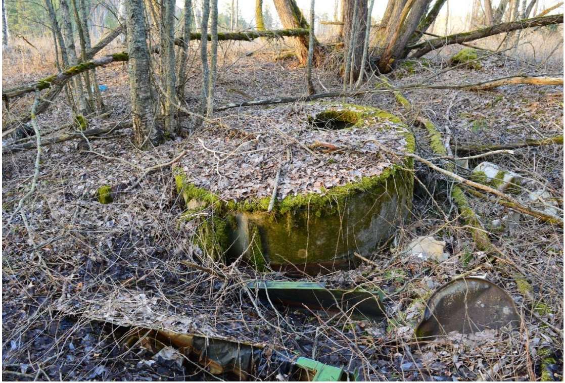
Kuva 16. Betoninen kaivo kaatopaikan lounaiskulmassa
