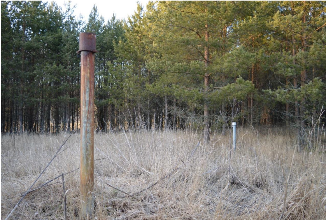
Kuva 11. Kaasunkeräyskaivo K1 kaatopaikan täytön päällä. Taustalla näkyy kaasuntarkkailuputki. Kaivosta oli havaittavissa metaanin hajua vuosien 2017 ja 2018 maastokäyntien yhteydessä.
