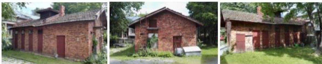
Kuva 23. Tiilisen piharakennuksen mittausnäkyvät kuvattu mittausspaikalla.
