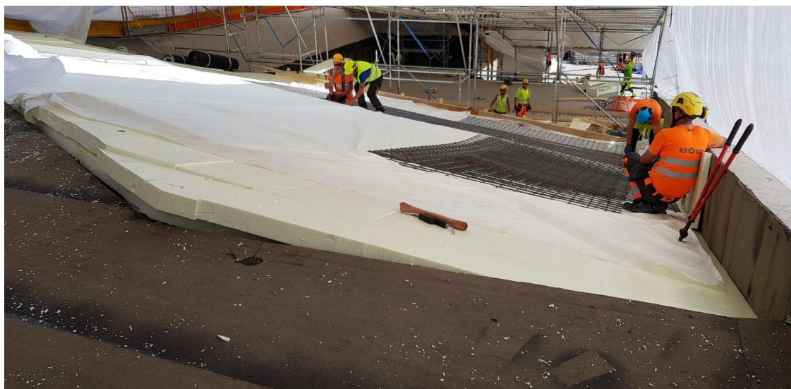
Kuva 10. Lämmöneristelevyjä vedeneristeen päällä.
