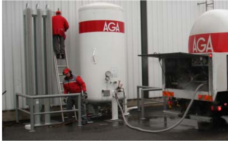
Kuva 34. Typpikaasulaitteiston asennus ja täyttö Yritys A:ssa.
