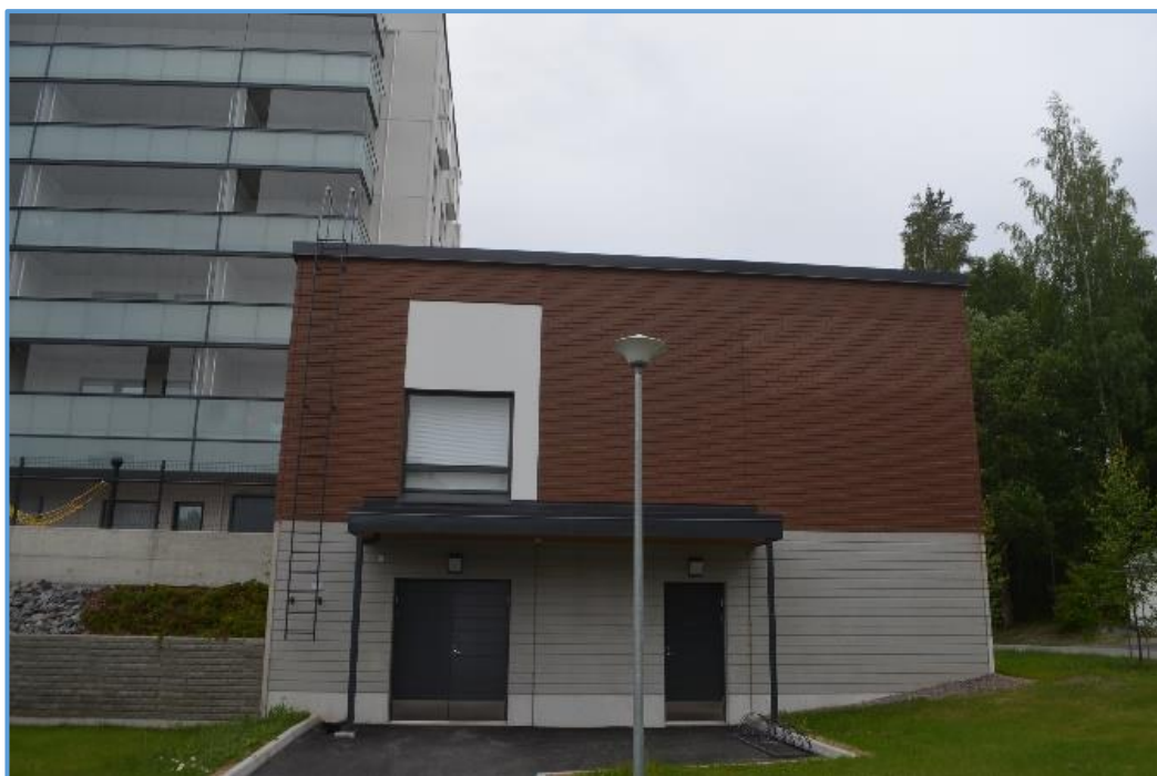
Kuva 8. Pyöräsuojan ovet ryhmäkodin päädyssä.
