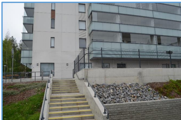
Kuva 6. Ristontalo rivitalojen B ja C välistä kuvattuna
