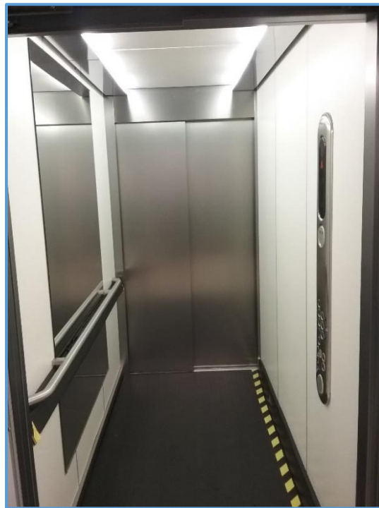
Kuva 14. Hissi sisältä porrashuoneen puolelta kuvattuna.
