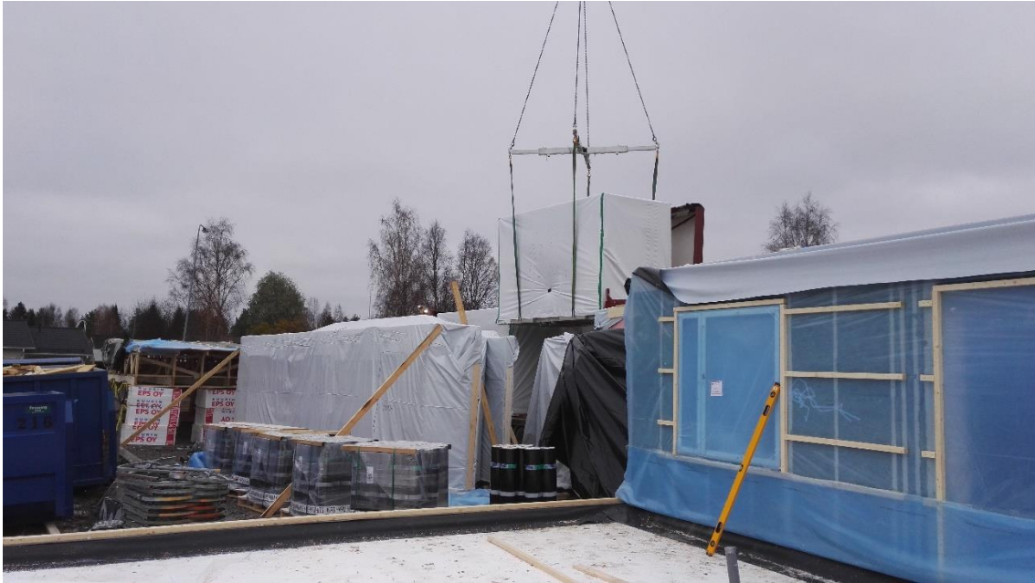
KUVA 9. Lehto Tilojen Esperi Care -työmaa Haapajärvellä; esivalmistettujen elementtien käyttöä. Kuvan etualalla ja keskellä ulkoseinäelementtejä, nostolaitteessa kylpyhuone-moduuli ja taustalla maajalassa koottu kattoelementti. (22, Kuva: Lauri Österberg)
