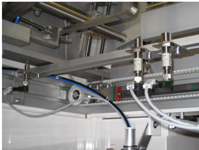
Kuva 10. Siirtolaite ja servon kotirajat
