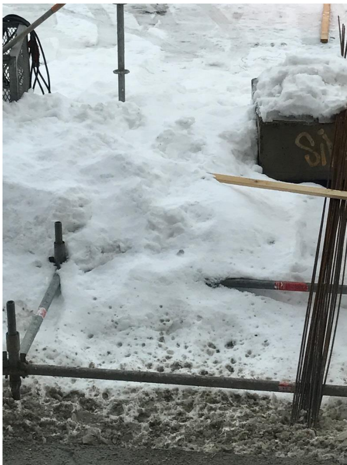
Kuva 24. Lumeen ja perusmaahan kiinni jääneet telineosat (Räsänen 2017-01-13)
