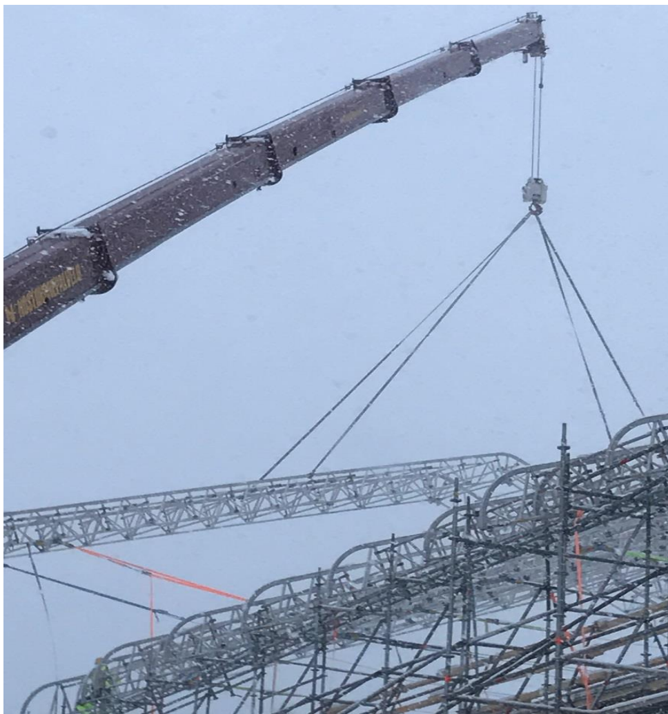
Kuva 23. Purkutyö käynnissä (Räsänen 2017-02-23)
