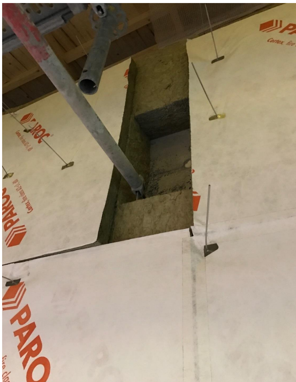
Kuva 22. Kiinnitys betonirunkoon (Räsänen 2017-01-23)
