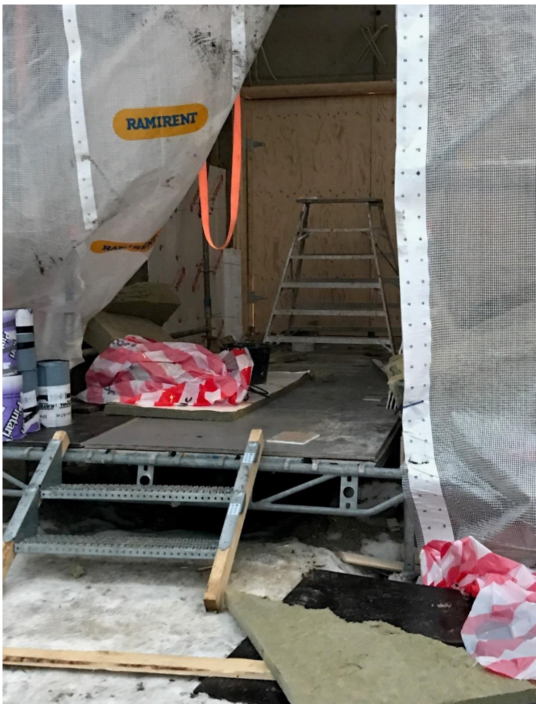
Kuva 18. Pääsisäänkäynnin laskutaso (Räsänen 2017-01-30)
