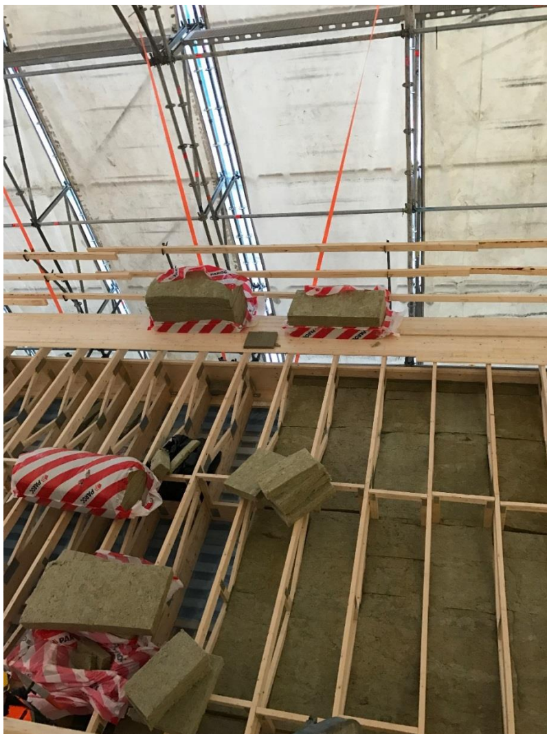
Kuva 1. Keskeneräinen eristystyö (Räsänen 2017-01-13)
