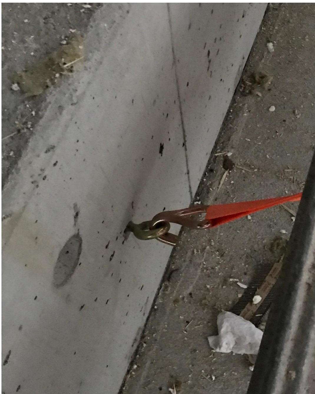
Kuva 20. Kiinnitys betonisokkeliin (Räsänen 2017-01-30)
