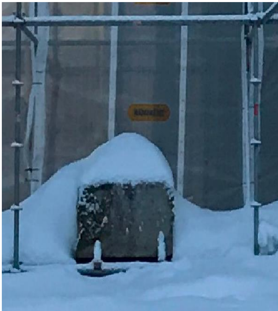
Kuva 21. Sääsuojan betonipaino (Räsänen 2017-01-16)
