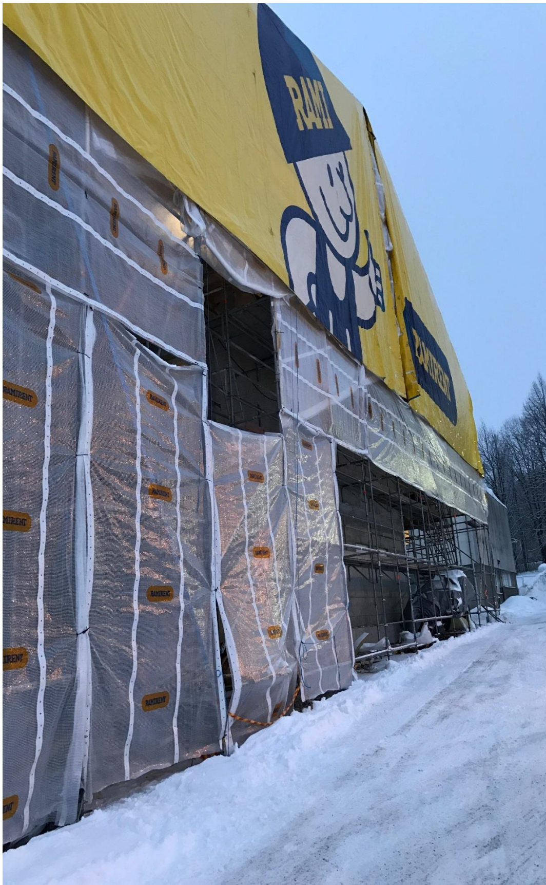
Kuva 19. Toisen kerroksen haalausaukko (Räsänen 2017-01-16)
