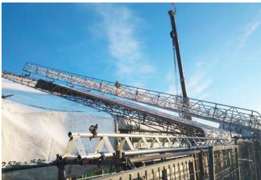
Kuva 5. Siirtokiskaisen sääsuojan kasaus (Ramirent.fi)
