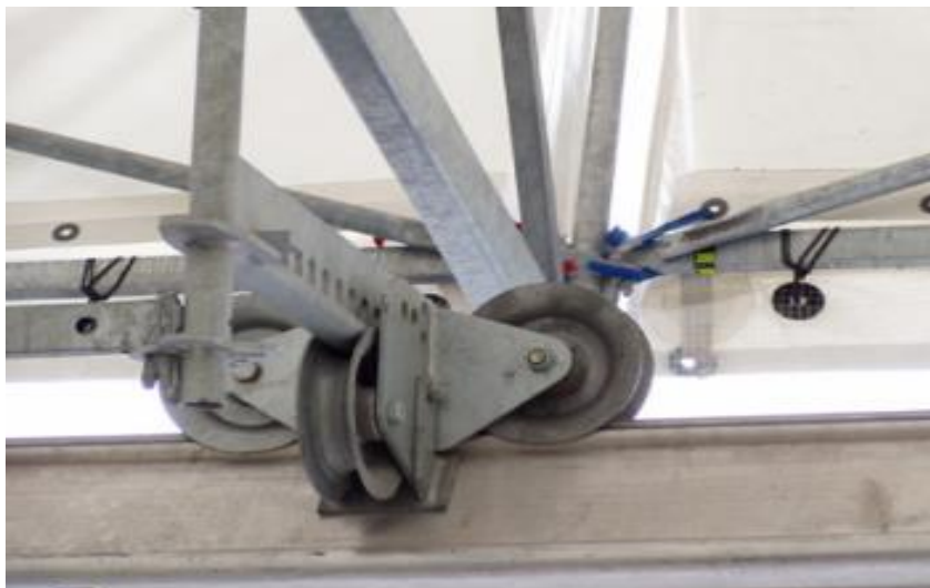
Kuva 6. Siirtokisko ja liukurenkaat (Ramirent.fi)
