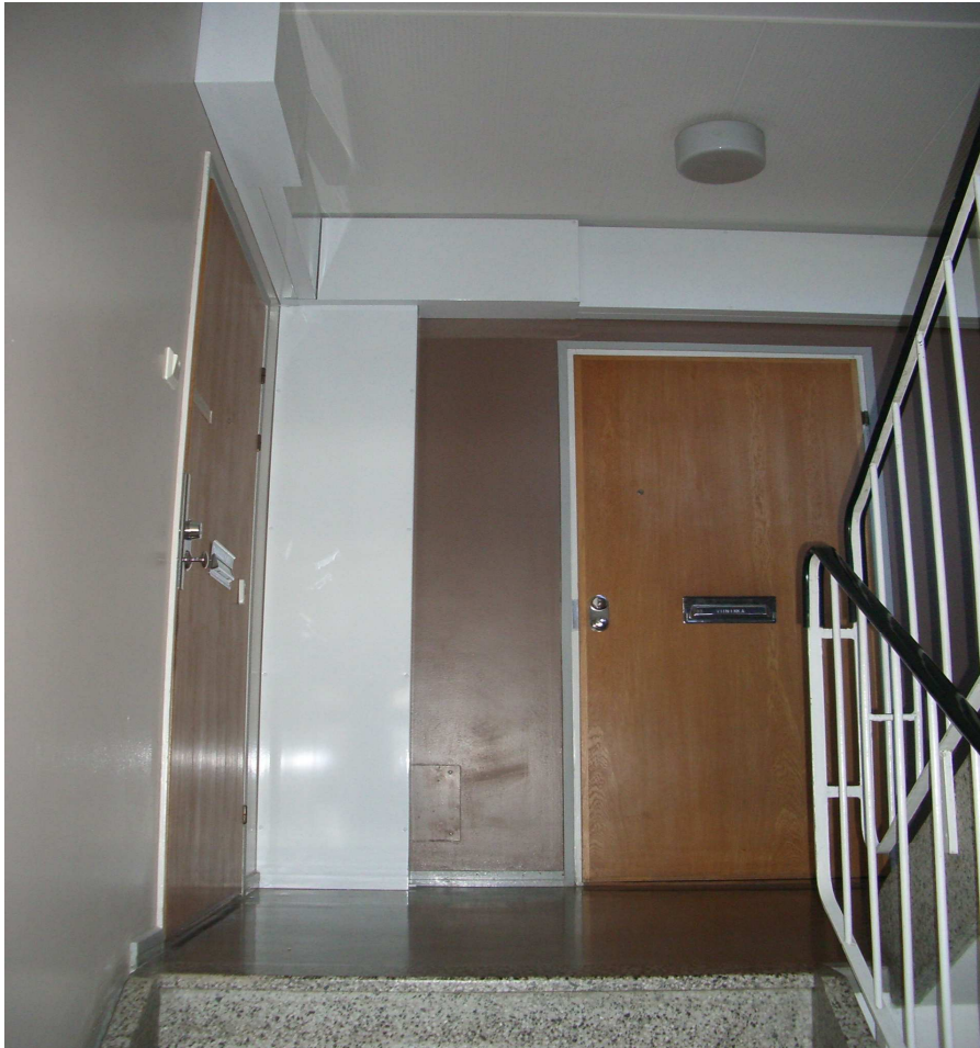
Kuva 5. Hormielementit asennetaan yleensä rappukäytävään.
