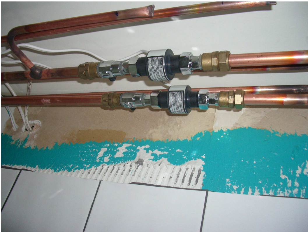
Kuva 6. Huoneistokohtaiset vesimittarit asennettuna kylpyhuoneen kattoon.
