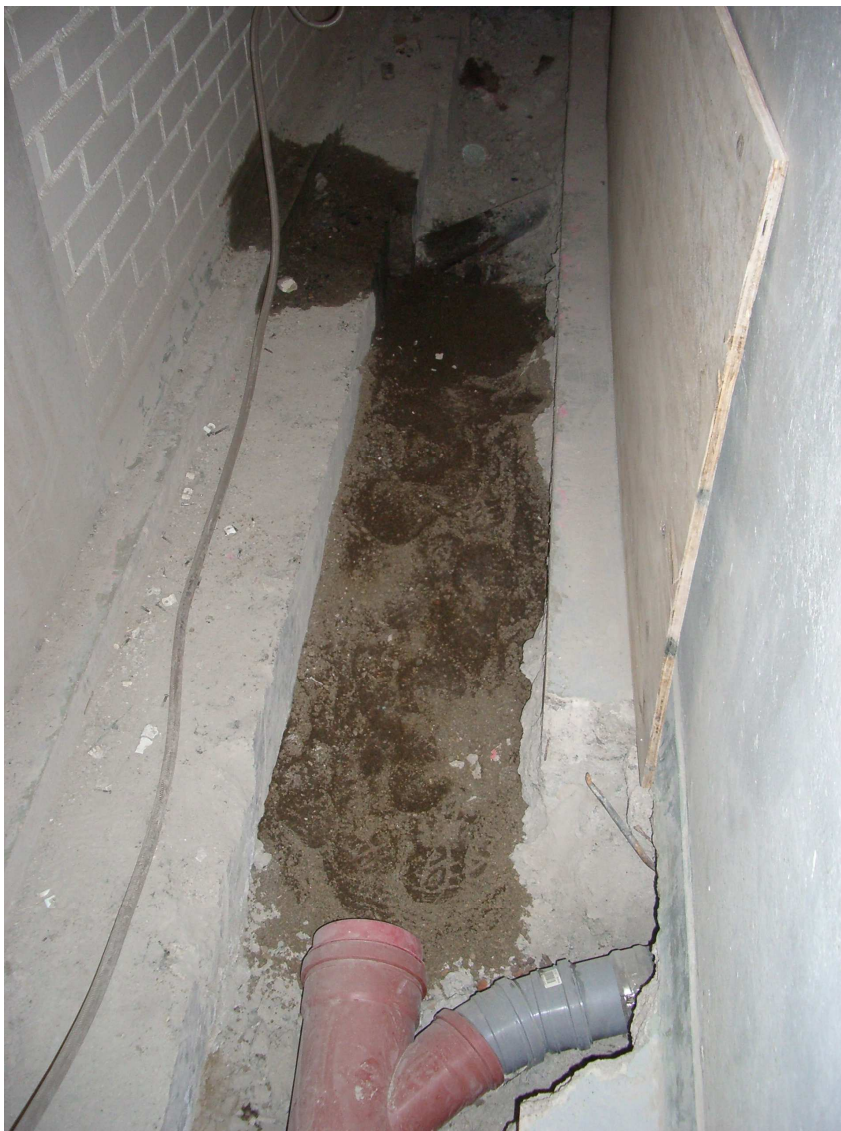
Kuva 1. Linjasaneerauksessa pohjaviemärin uusiminen vaatii lattian sahauksen
