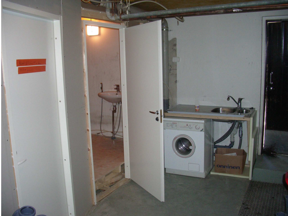
Kuva 9. Väliaikaiset saniteettitilat ovat usein kylmiä tiloja.
