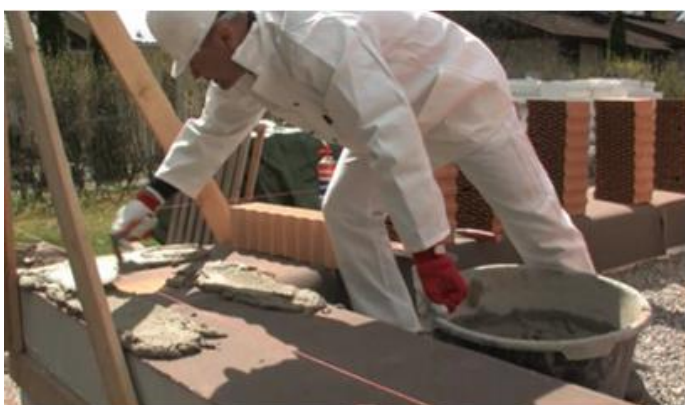
Kuva 25. Ensimmäisen kerroksen tasaava laastikerros sekä PU-vaahtoväli (Wienerberger 2018c).
