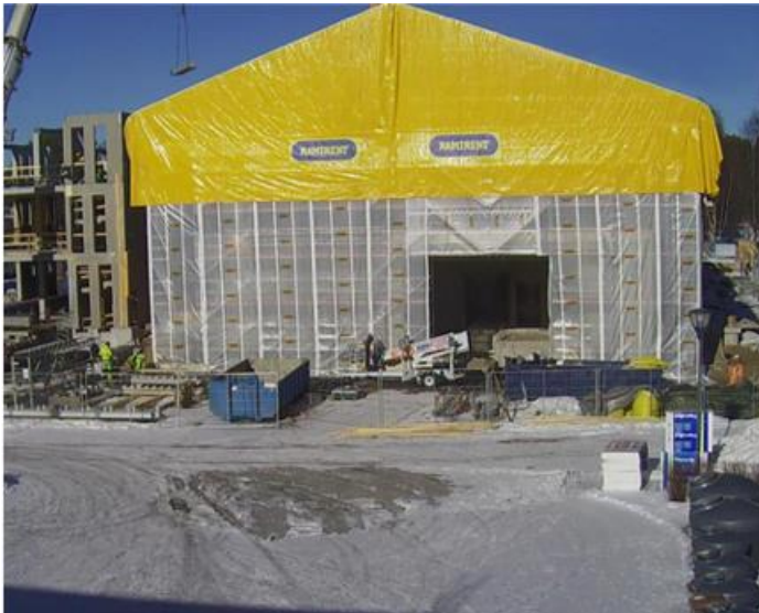
Kuva 50. Ramirentin rakennuksen kokonaan peittävä sääsuoja (Rautio 2017).
