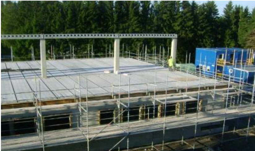
Kuva 46. Esimerkkikuva telineistä, jotka kulkevat rakennuksen ulkopuolella (Seitz 2017).
