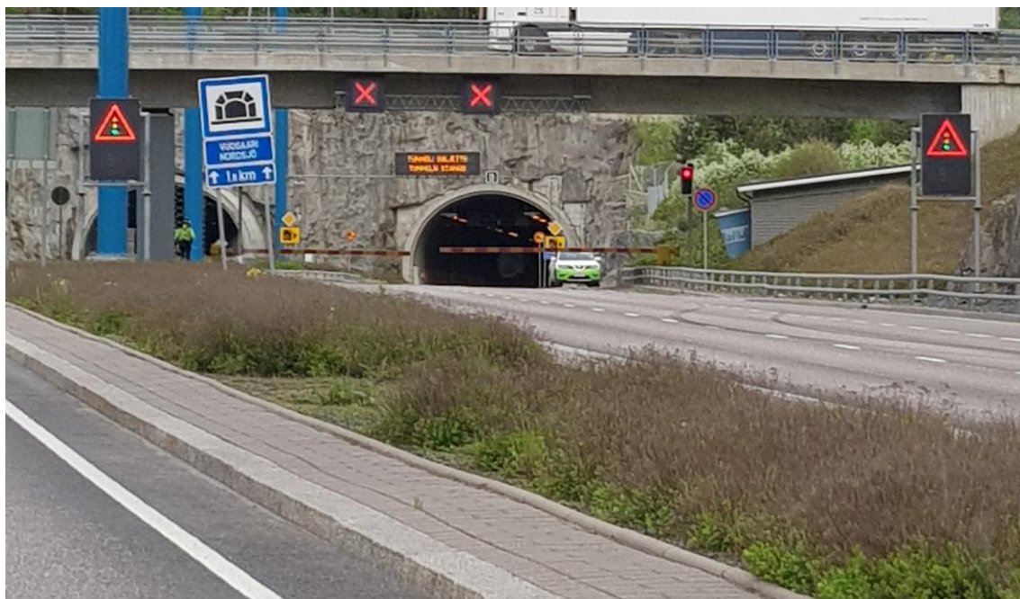
Kuva 9. Vuosaaren tunnelin testaukset 18.5.2018. Tunneli oli suljettu ja liikenne ohjattu kiertoreitille.
