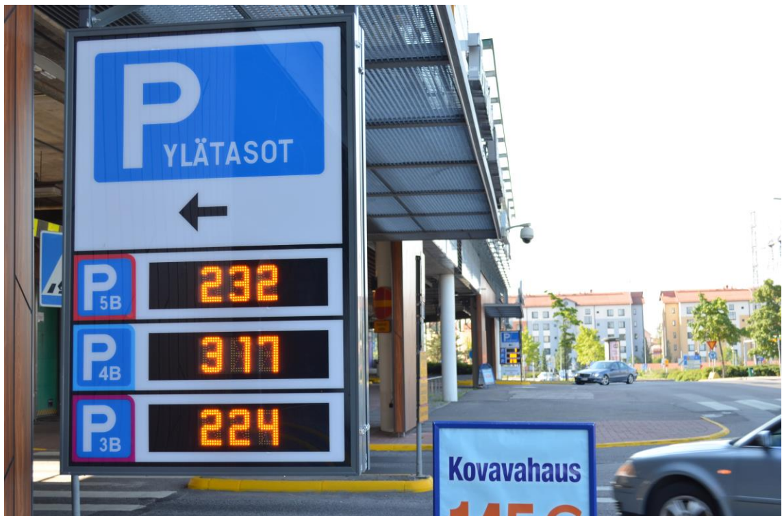
Kuva 2. Pysäköintihallin sisäänkäynnillä oleva muuttuva opaste kertoo vapaiden paikkojen määrän kerroskohtaisesti.
