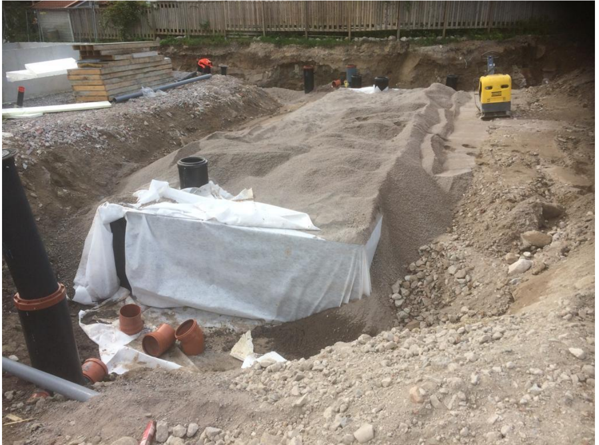
Kuva 2. Kasettikenttä vuorattuna suodatinkankaalla.
