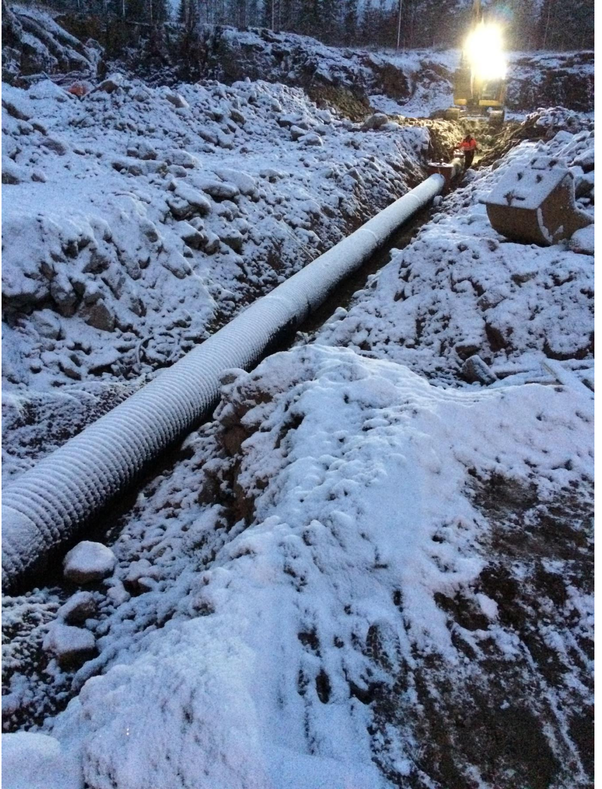
Kuva 3. Viivästyslinjan tekoa suurilla putkilla.
