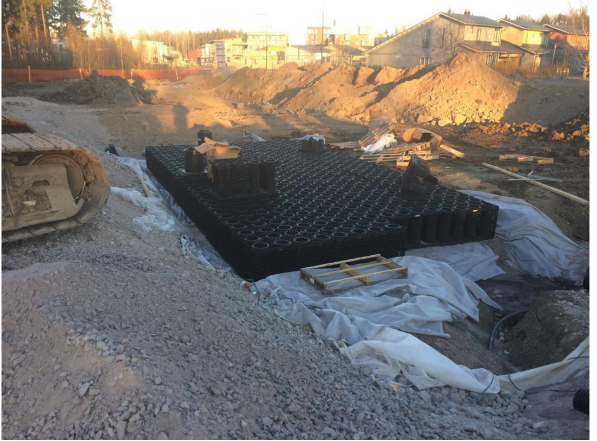
Kuva 1. Kasettikentän kokoamista.
