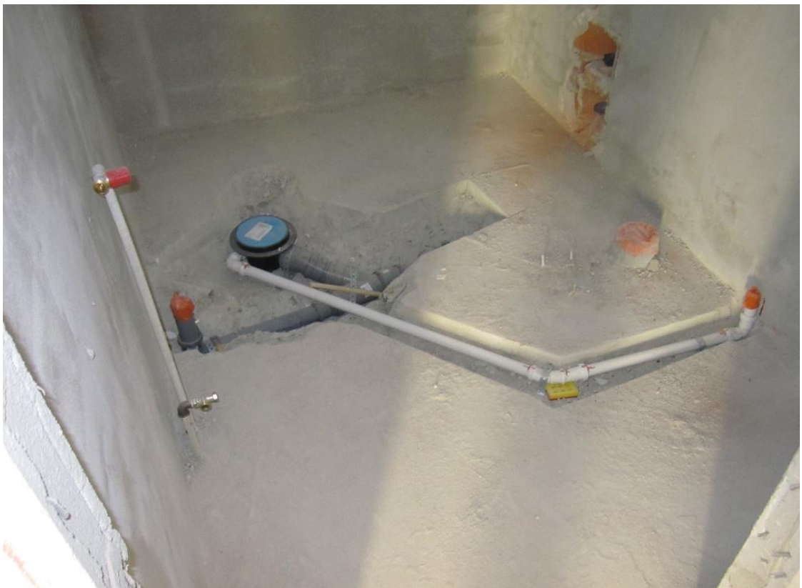
Kuvio 5. Uritettu kylpyhuoneen lattia, jossa uudet putket paikallaan valua varten.
