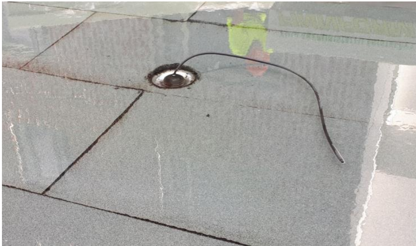
Kuva 4. Vesikatolla tehtävä vedenpainekoe, kaivon vedenpitävyyden varmistumiseksi.
