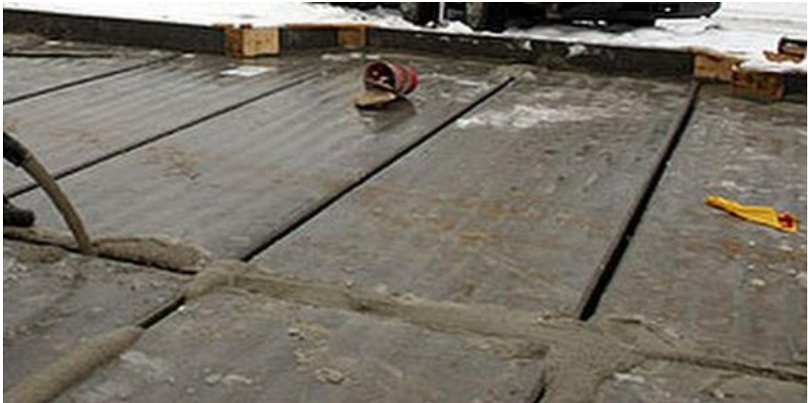
Kuva 16. Saumat valetaan ja lopuksi puhdistetaan.
