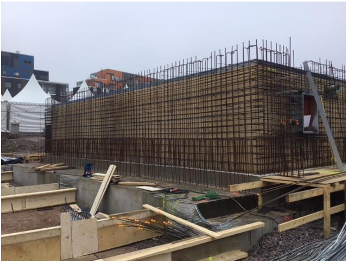
Kuva 15. Väestönsuojan raudoitustyöt käynnissä.
