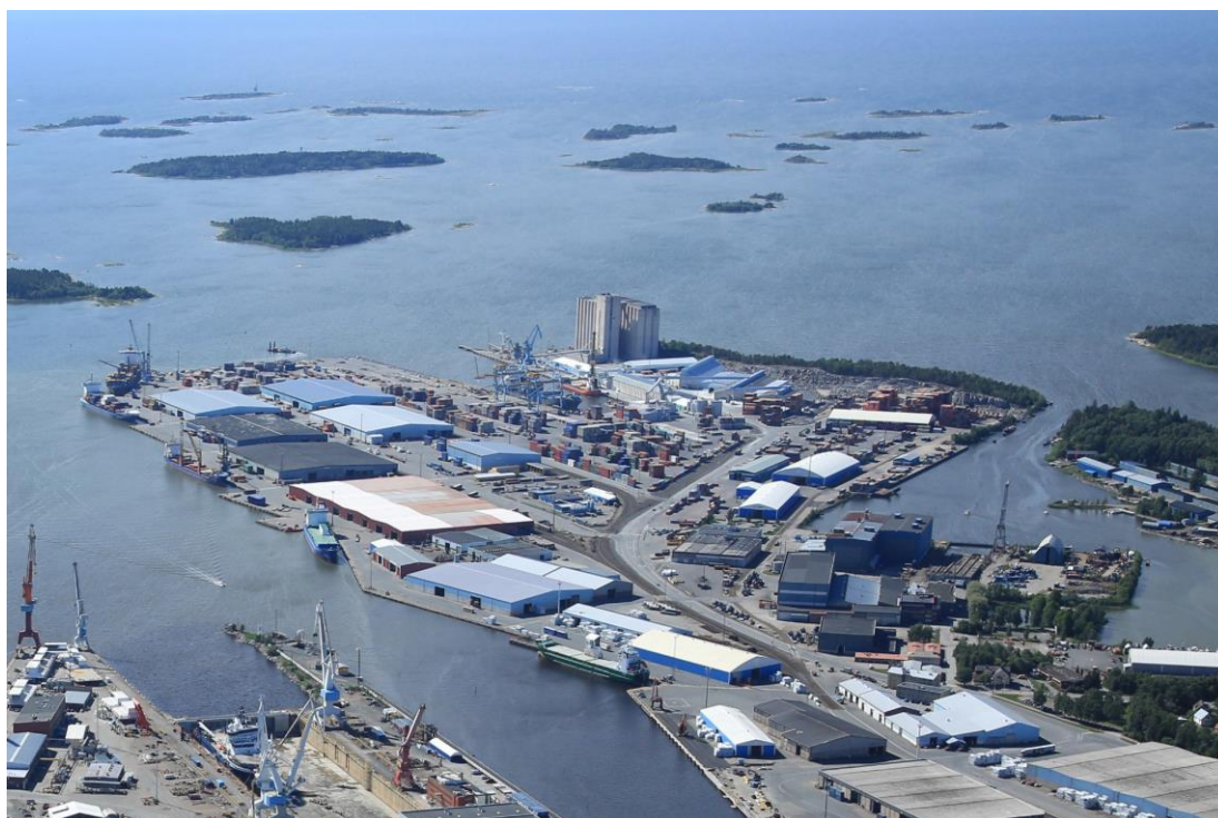
Kuva 1 Ilmakuva Euroports Rauma Oy:n alueesta (Rauman Meriteollisuuskiinteistöt Oy)
