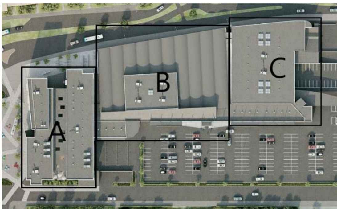
1SAMK-Uusi kampus ( Satakunnan ammattikorkeakoulun Sokopro 2018)
