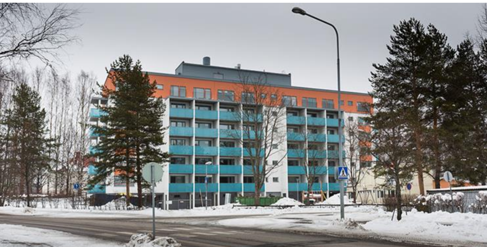
Kuva 11. Hakapaavo julkisivuremontin ja lisäkerrosrakentamisen jälkeen. Kuva Consti.
