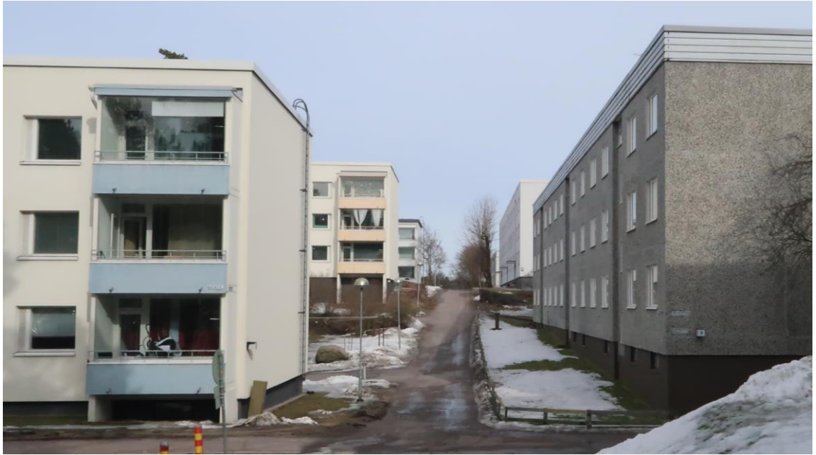
Kuva 16. Näkymä Matintiestä itään. Oikealla olevan talon pesubetonipinta ja korkea räystääspellitys ovat alueella tyypillistä alkuperäistä arkkitehtuuria. Kuva Nina Virtanen.
