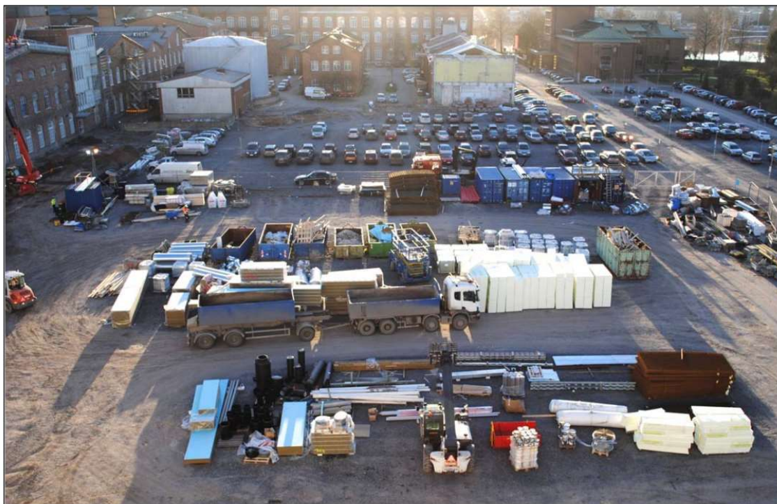
Kuva 3, Skanska, Porin puuvillan työmaan varastoalue [16.]
