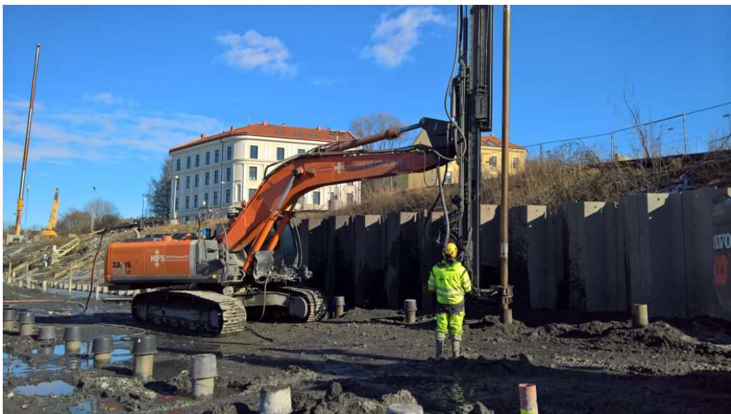
Kuva 1. KFS:n Teräspuutkipaalutus kalustoa,
