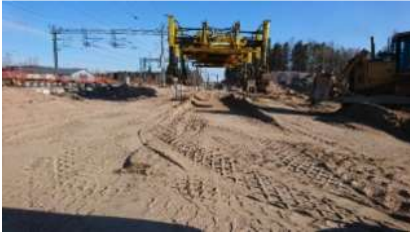
Kuva 4. Railtek Oy:n vaihteenasennuskone (kuukävelijä) Desec TL. Lähde: https://www.railtek.fi/kalusto
