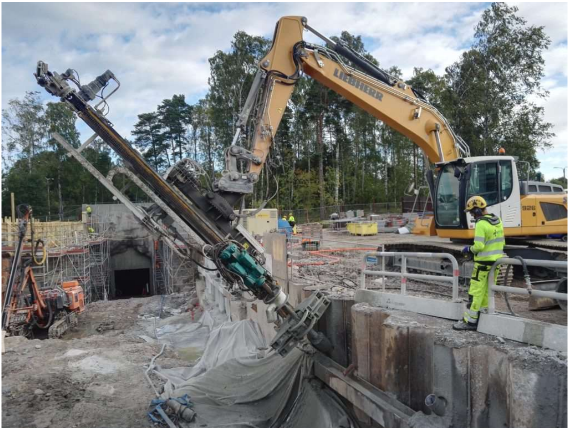
Kuva 3. KFS:n tukiseinien ankkurointikalusto, lähde: https://www.kfs.fi/kfs_palvelut/tukiseinat-ja-ankkurointi/
