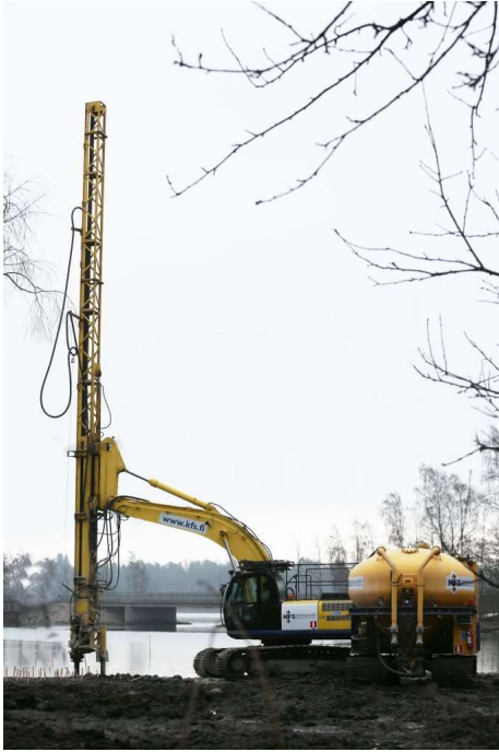
Kuva 2. KFS:n Stabilointikalustoa. Lähde: https://www.kfs.fi/kfs_palvelut/syvastabilointi/
