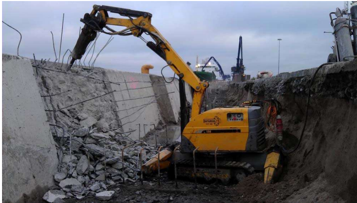
Kuva 21. koneeseen kiinnitetty rammeri eli piikkaus vasara.
