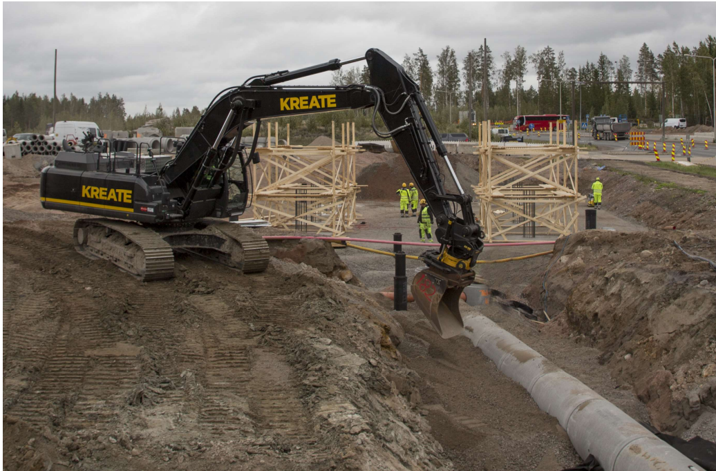
Kuva 8. Kreation uusi 35t Liebherrin tela-alustainen kaivinkone. Lähde: Heska Korhonen, Kreate Oy.
