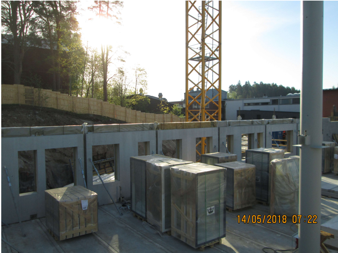
Kuva 15 Holville valmiiksi nostettuja ikkunanippuja
