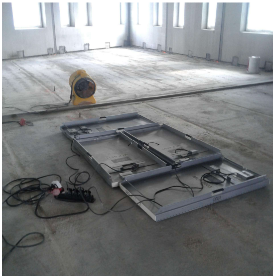
Kuva 6 Ontelolaataston kuivattamista lämpölevyillä
