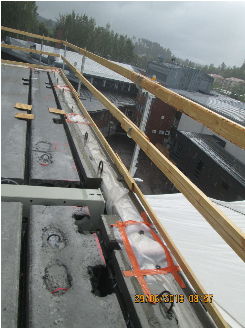
Kuva 20 Asennettuja elementtejä, joiden saumat on suojattu
