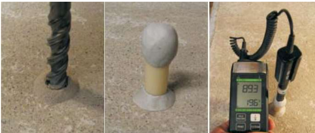
Kuva2 Mittausreiän poraus, tiivistetty reikä jossa kosteus tasaantuu ja kosteuden mittaus (RT 14-10984)
