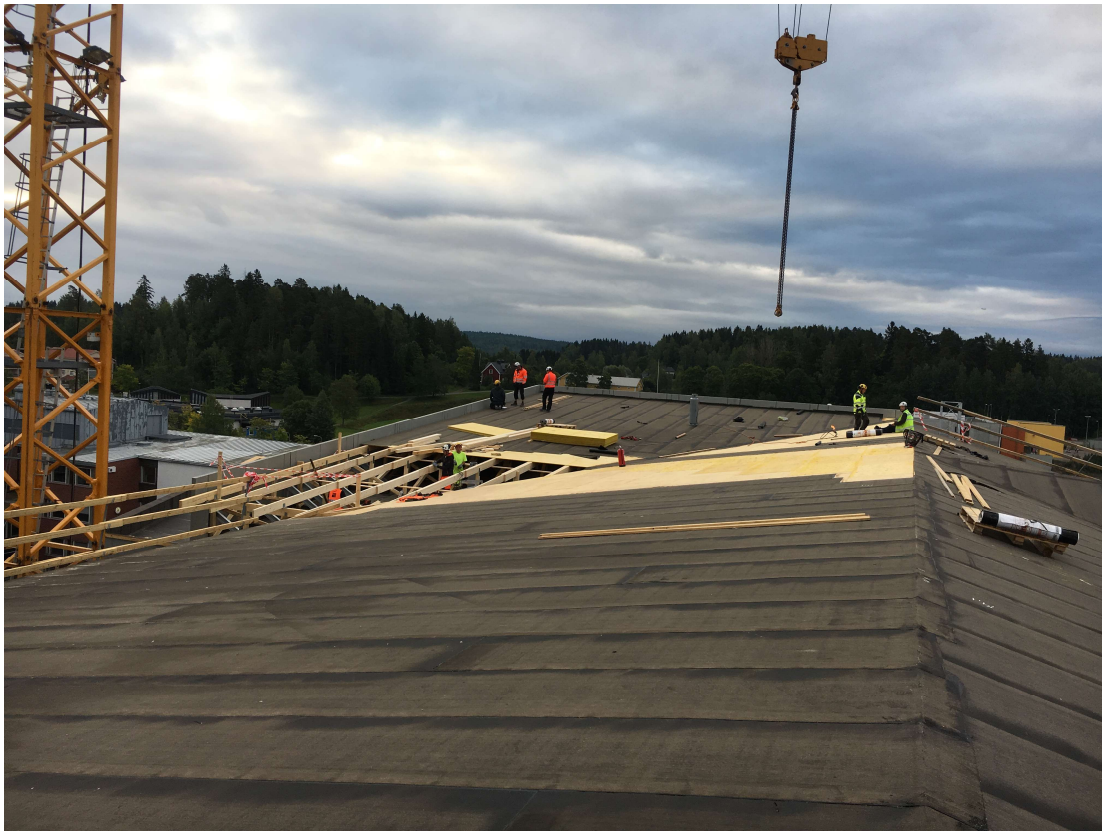
Kuva 13 Viimeinen lohko käynnissä
