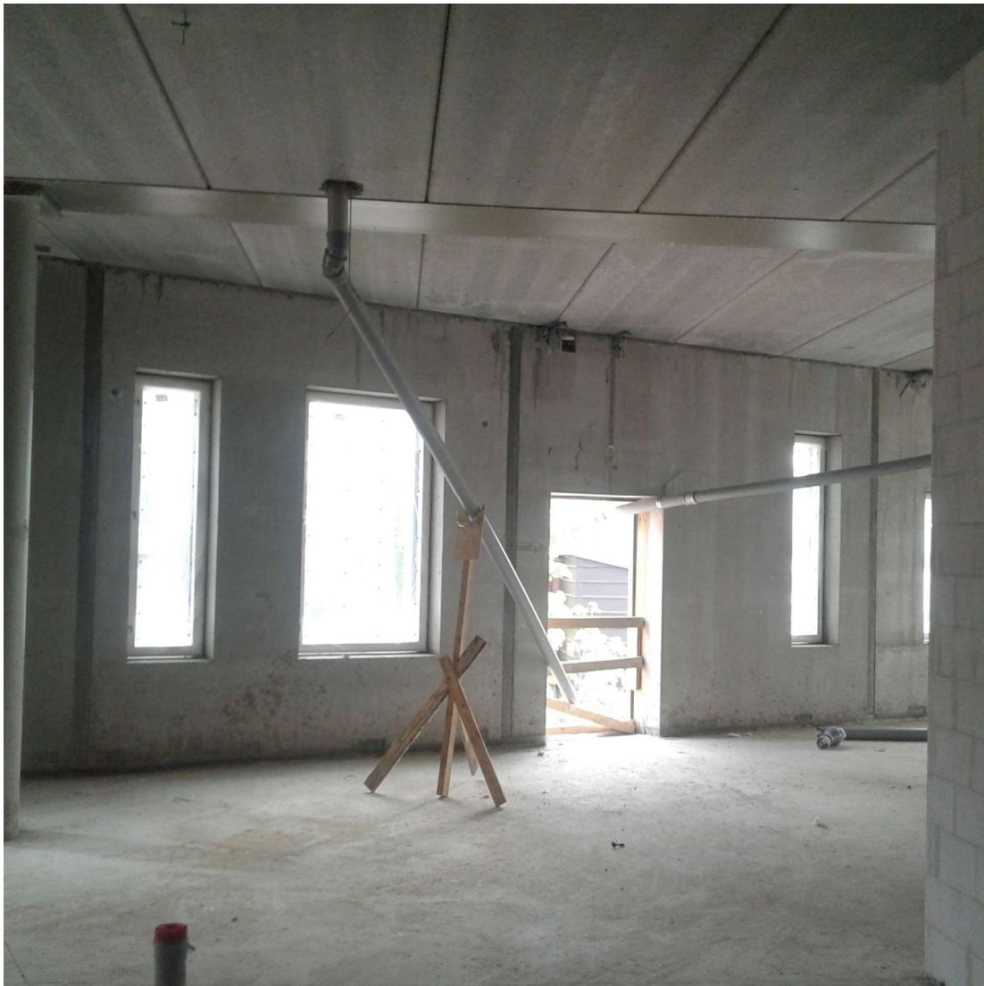
Kuva 12 Väliaikainen vedenpoisto yläpohjasta
